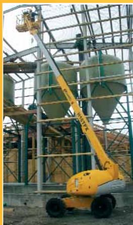
Eine H16TPX in vollem Einsatz auf einer Baustelle in Warschau.
